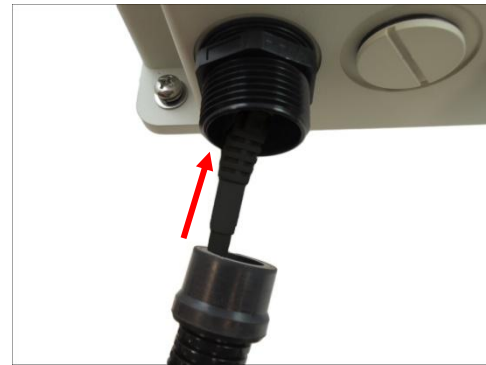
Using the Conduit Gland
