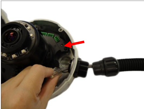
Using Flex Conduit
