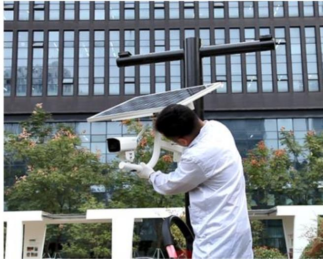
Es ist kein zusätzliches Netzkabel und kein Netzkabelanschluss erforderlich
